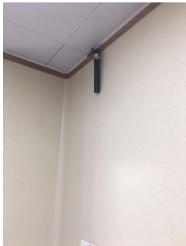
图 3-12 \gamma 辐射监测报警仪控制室探头
