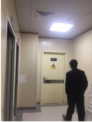
图 3-14 分装室机房门电离辐射警示
