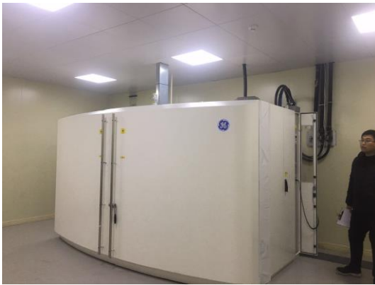
图 3-16 回旋加速器机房进风口
