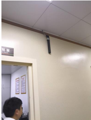
图 3-10 \gamma 辐射监测报警仪走廊探头
