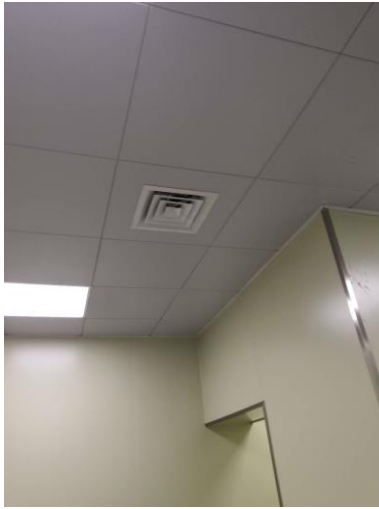
图 3-16 回旋加速器机房进风口
