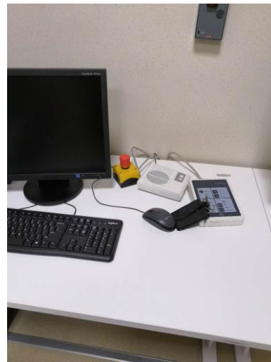
图 3-21 后装治疗机控制室急停按钮
