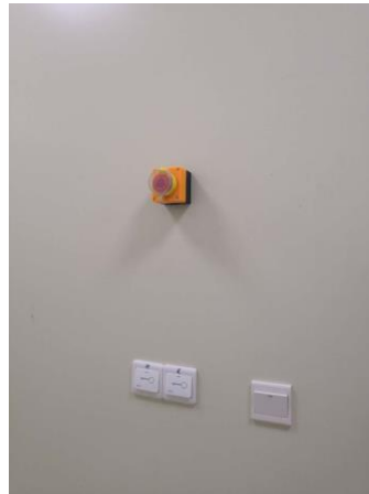
图 3-21 后装治疗机控制室急停按钮
